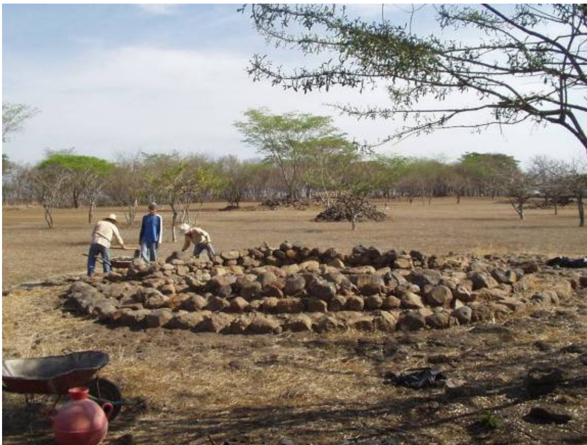
FIGURA 9:6 Trabajos de consolidación en la Estructura P-28.
