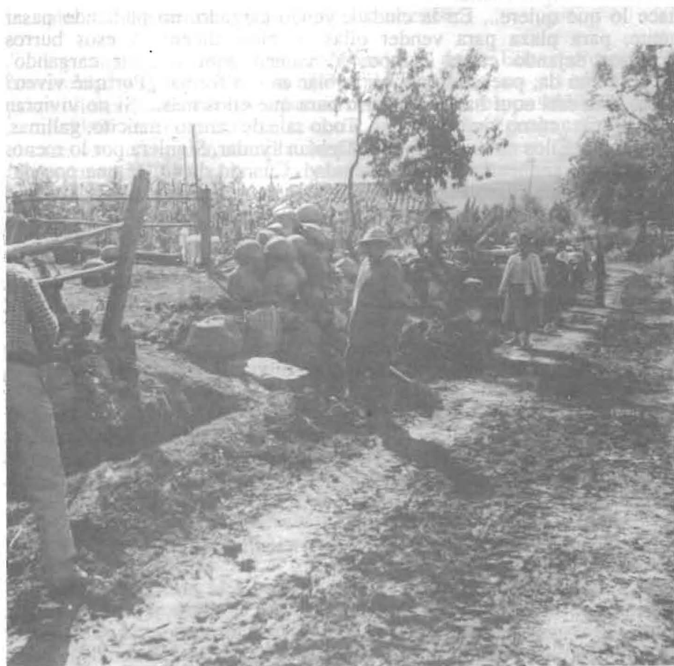
Foto 4.- Trabajando en minga una zanja.
