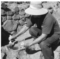
FIGURA 9:5 Aplicación del consolidante de piedra OH-100 a los elementos de talpetate en el lado norte de la Estructura P-5.
